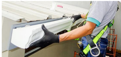
Figura N° 13.- Sustitución de componentes
