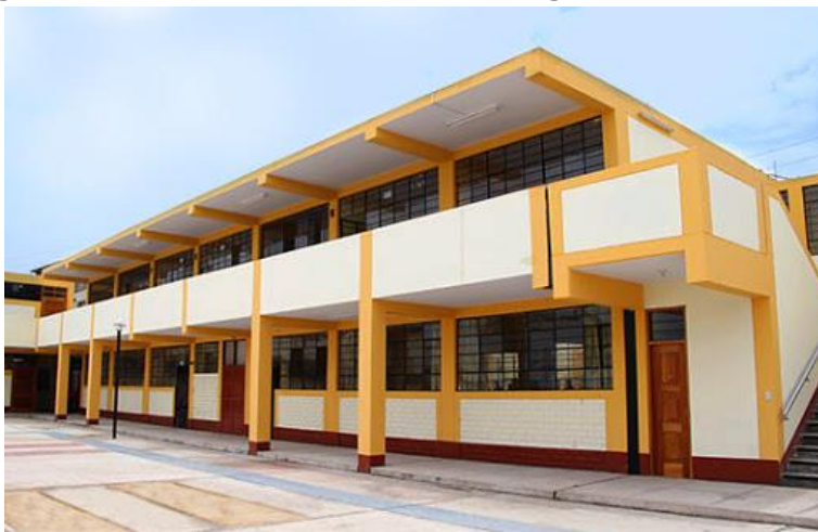
Figura N ° 1.- Edificación con techo aligerado de concreto
