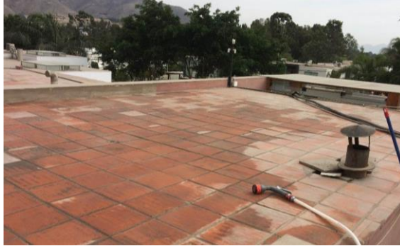
Figura N ° 6.- Mantenimiento de ladrillos pasteleros
