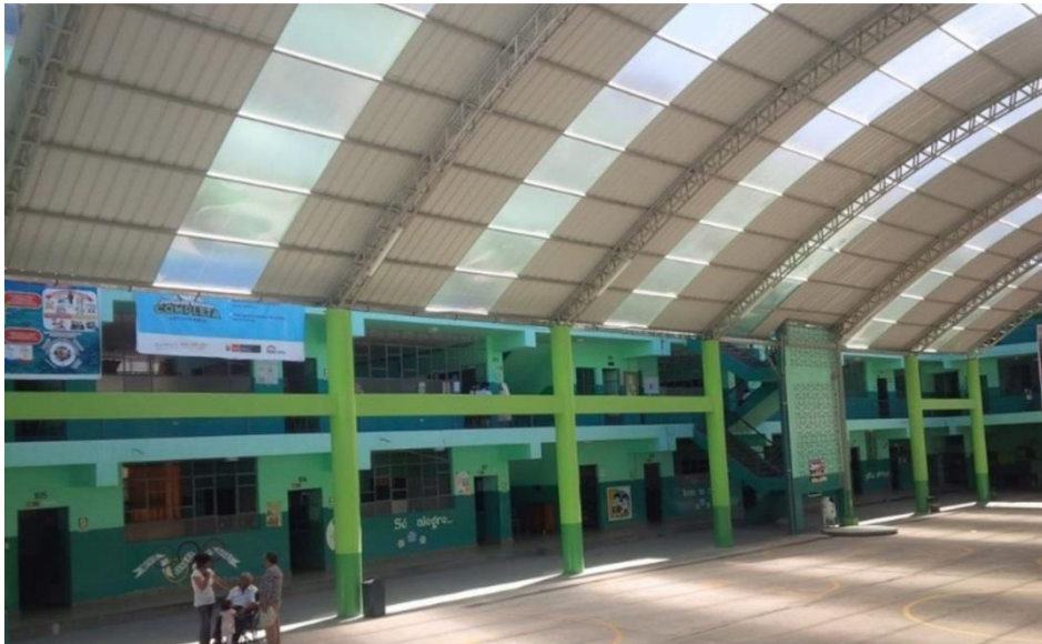
Figura N ° 3.- Cubierta en patio con materiales opacos y traslúcidos
