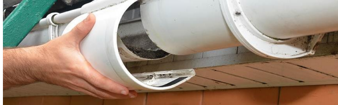
Figura N° 14.- Sustitución de componente de unión
