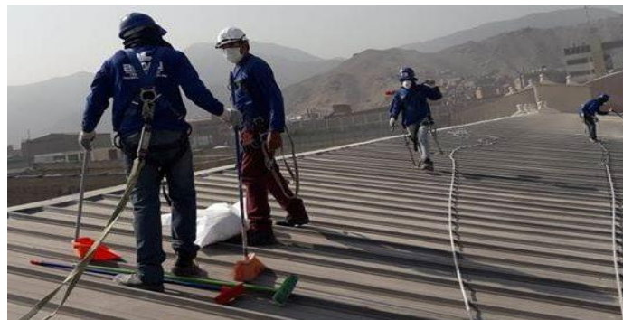
Figura N ° 5.- Limpieza de techo liviano metálico
