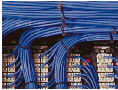
Figura N° 7.- Cintillos (cinchos) para peinar cables
