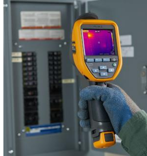
Figura N° 9.- Uso de cámara de temperatura (termográfica)
