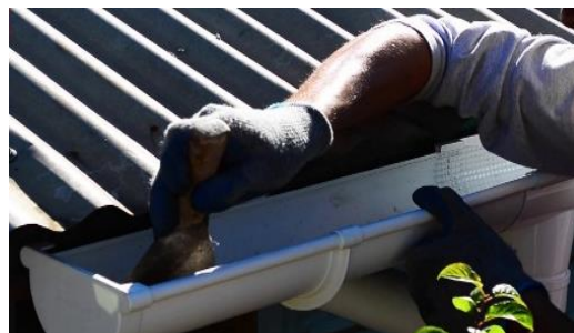
Figura N° 8.- Limpieza de canaleta
