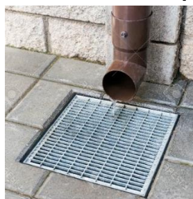
Figura N° 5.- Sumidero pluvial
