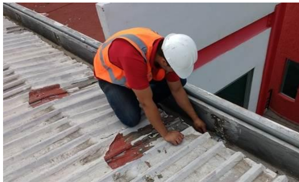
Figura N° 7.- Mantenimiento de drenaje pluvial
