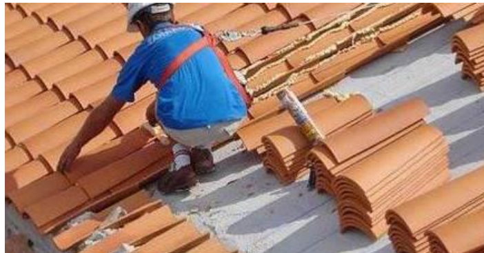
Figura N ° 4.- Mantenimiento de techo inclinado con tejas
