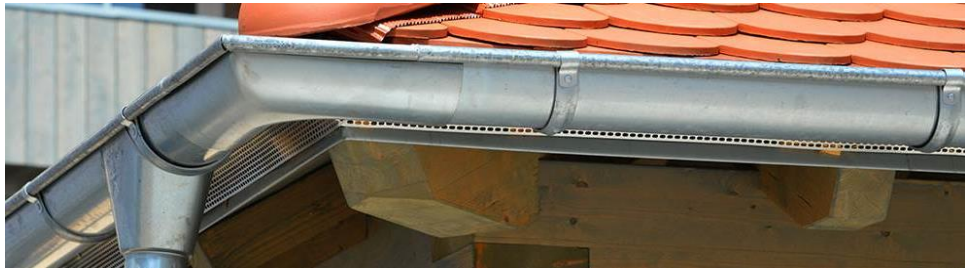
Figura N° 11.- Sistema de drenaje pluvial de aluminio
