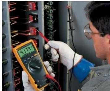
Figura N° 10.- Uso de multímetro en tableros
